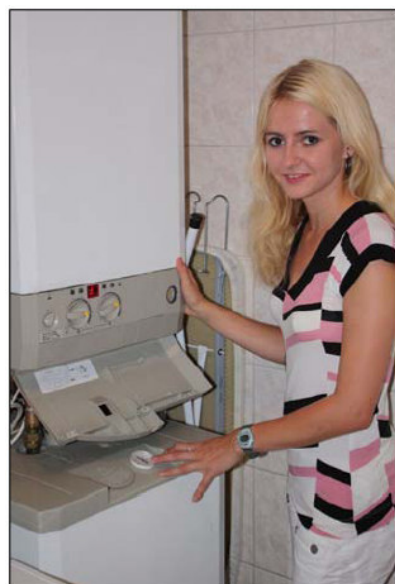
Obr. 2: Pravidelná kontrola kotle.
